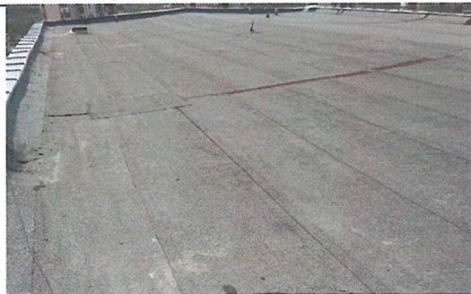
Плосък топъл покрив – тип 3
